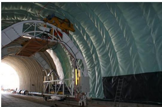
Гидроизоляционная мембрана FLAGON BSL на лицевой поверхности мембраны имеет тонкий цветной слой, который позволяет быстро визуально обнаружить любые повреждения, возникшие при монтаже. Этот слой называется "сигнал-слой".
