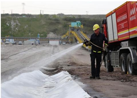
TILTEX® раскатывается на предварительно подготовленное основание, при необходимости закрепляется механически после чего смачивается путем распыления воды со следующим расходом:
