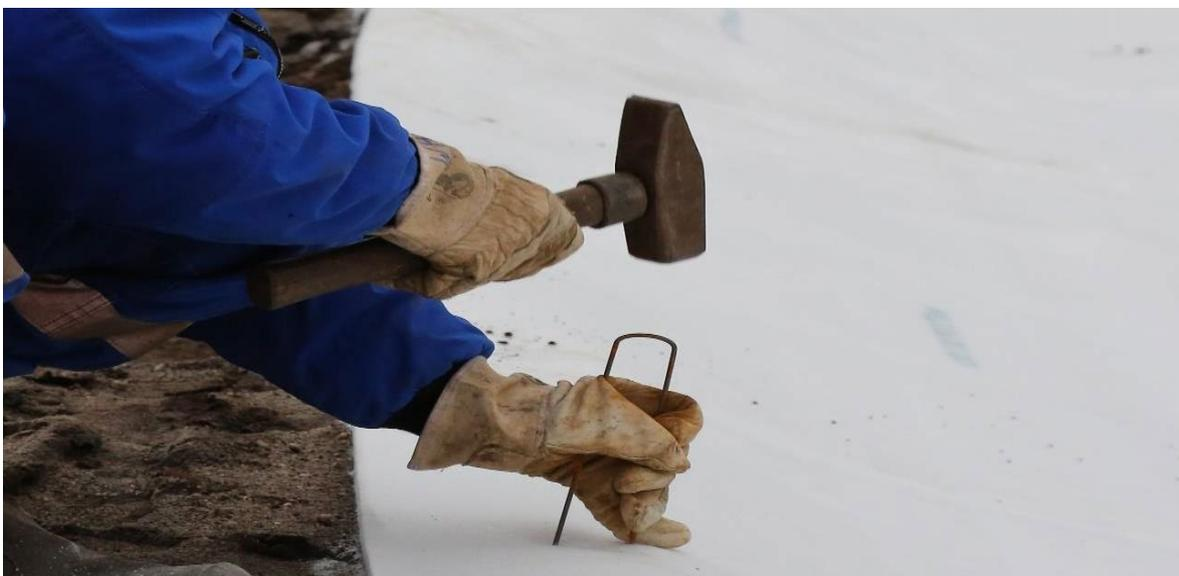
**Tiltex® P** – анкерные крепления из оцинкованной стали. Предназначены для крепления бетонного полотна TILTEX® в мягкие и твердые грунты (Таблица 2). Система **Tiltex® P** легко и быстро монтируется при помощи насадки для сверлильного инструмента **Tiltex® P Tool**.
