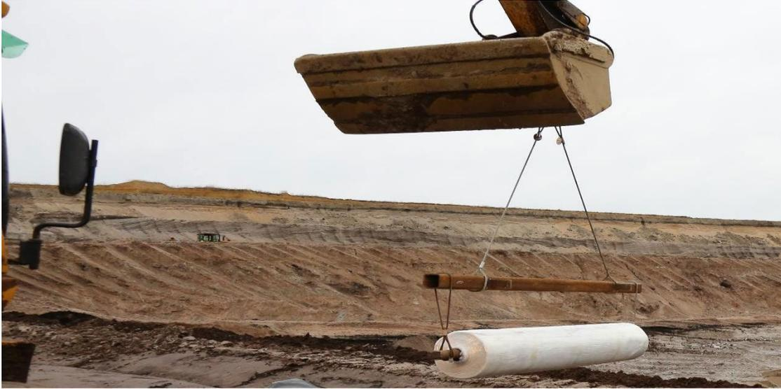
6.3 При укладке последующих слоев бетонного полотна нахлест (перехлест) полотен должен быть не менее 10 см в направлении потока воды.
