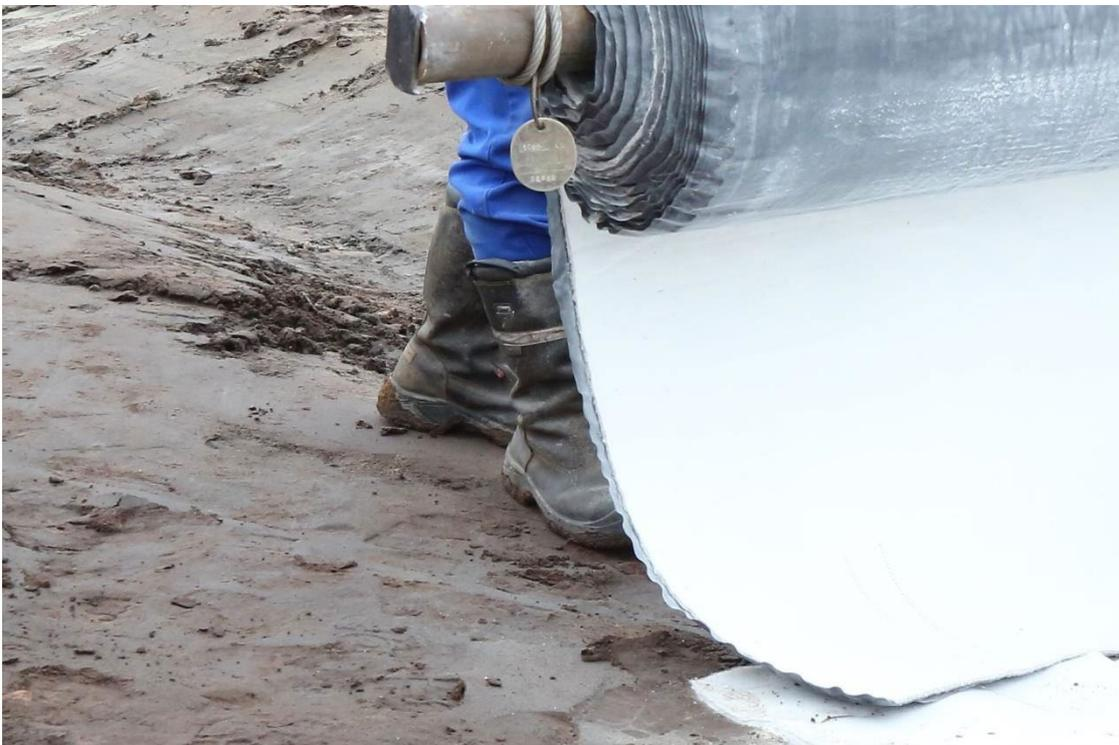
6.2 Разгрузочно-погрузочные работы и подача рулонов к месту укладки осуществляется при помощи подъемного автокрана, фронтального погрузчика или другого устройства, которое позволяет поднимать рулоны. Траверса или металлическая рейка помогут облегчить и ускорить сроки монтажа материала.
